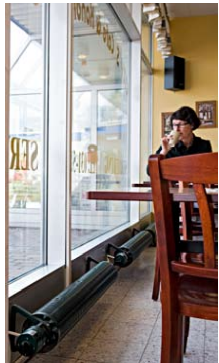
Das Design der Rippenheizkörper und der Wandhalterungen erleichtern die Installation, beispielsweise unter einem Fenster.
