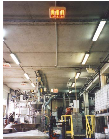
IRCF werden oft in großen Lagerhäusern installiert, da sie für schnelle, effektive und kostengünstige Wärme sorgen.
