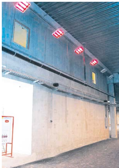
IRCF können an der Wand oder an der Decke montiert werden und eignen sich besonders gut für Gebäude, die sporadisch genutzt werden, wie diesen Startbereich einer Gokart-Bahn.
