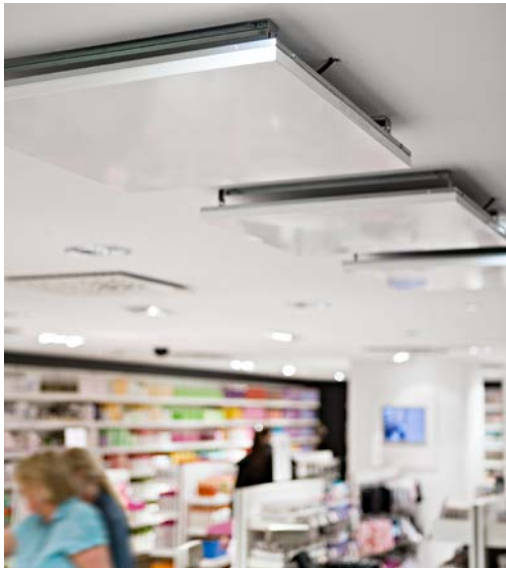
Die Deckenmontage schützt die Thermocassette gegen Beschädigungen.
