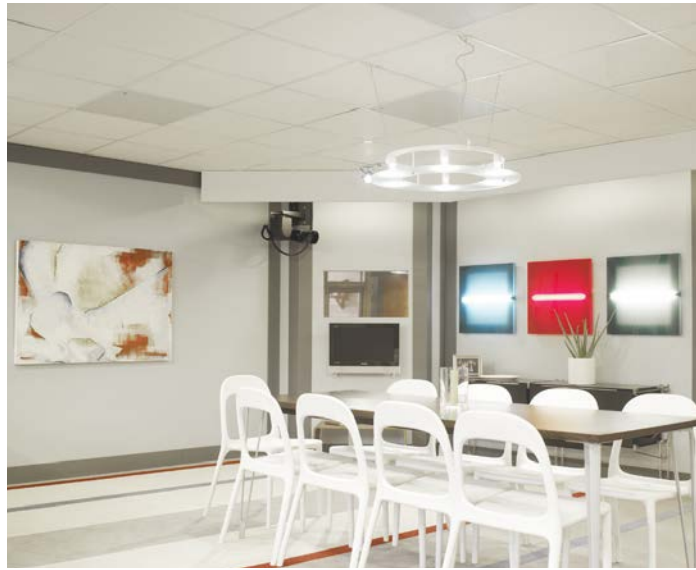
Eine Thermocassetten-Heizung in einer Zwischendecke ist eine attraktive und fast unsichtbare Heizmöglichkeit. Die Lage der Heizkassetten kann bei einer veränderten Raumnutzung sehr einfach geändert werden.
